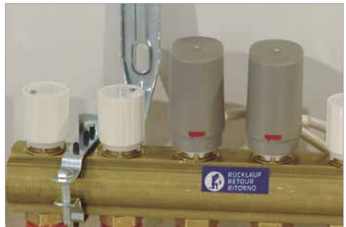
Электротермические сервоприводы, установленные на коллектор.
